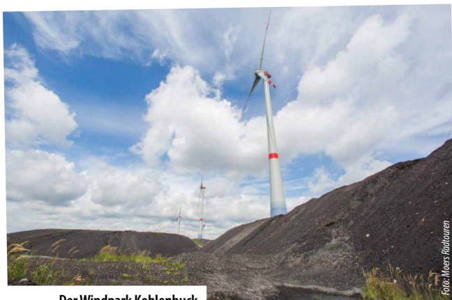
Der Windpark Kohlenhuck.
